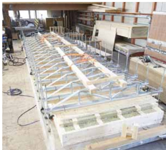
Alternative zur Vakuumpresse: Mit dem pneumatischen Pressensystem können Kasten-elemente auf dem Elementbautisch produziert werden
