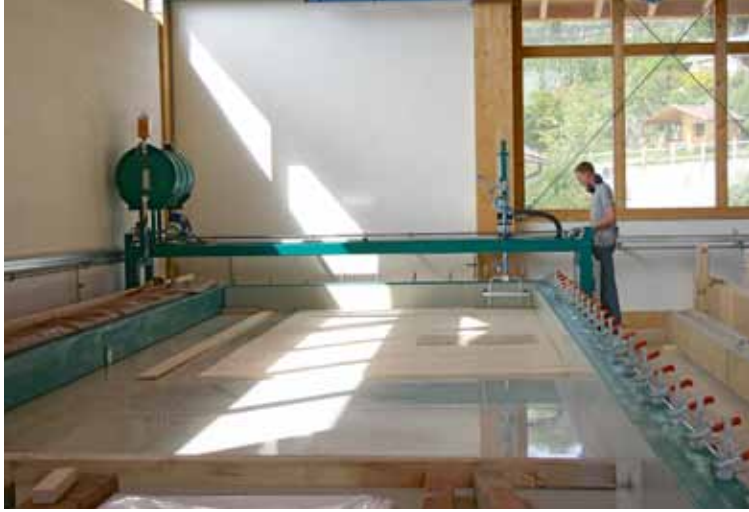
Der Mitarbeiter von Lobis Elements überwacht den Auftrag des einkomponentigen PUR-Klebstoffs am mitgelieferten Woodtec-Leimportal
