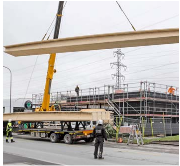
Abb. 4: Holz und Klebstoff trumpfen einmal mehr: So effizient und kostengünstig hat man bei der AMAG noch keine Ausstellungshalle gebaut.
