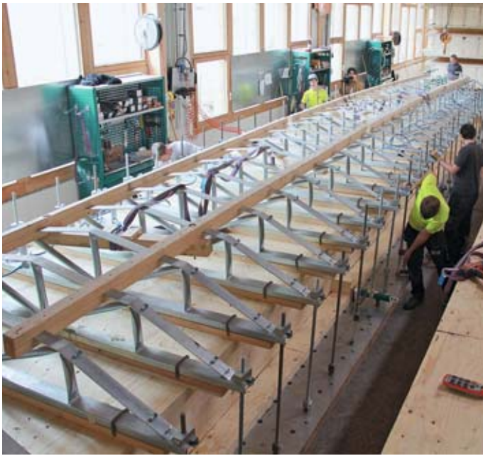
Abb 3: Die 19 m langen Kastenelemente werden mit einem pneumatischen Pressensystem während 12 h verpresst. Bei einem Druck von 160 t pro Element.
