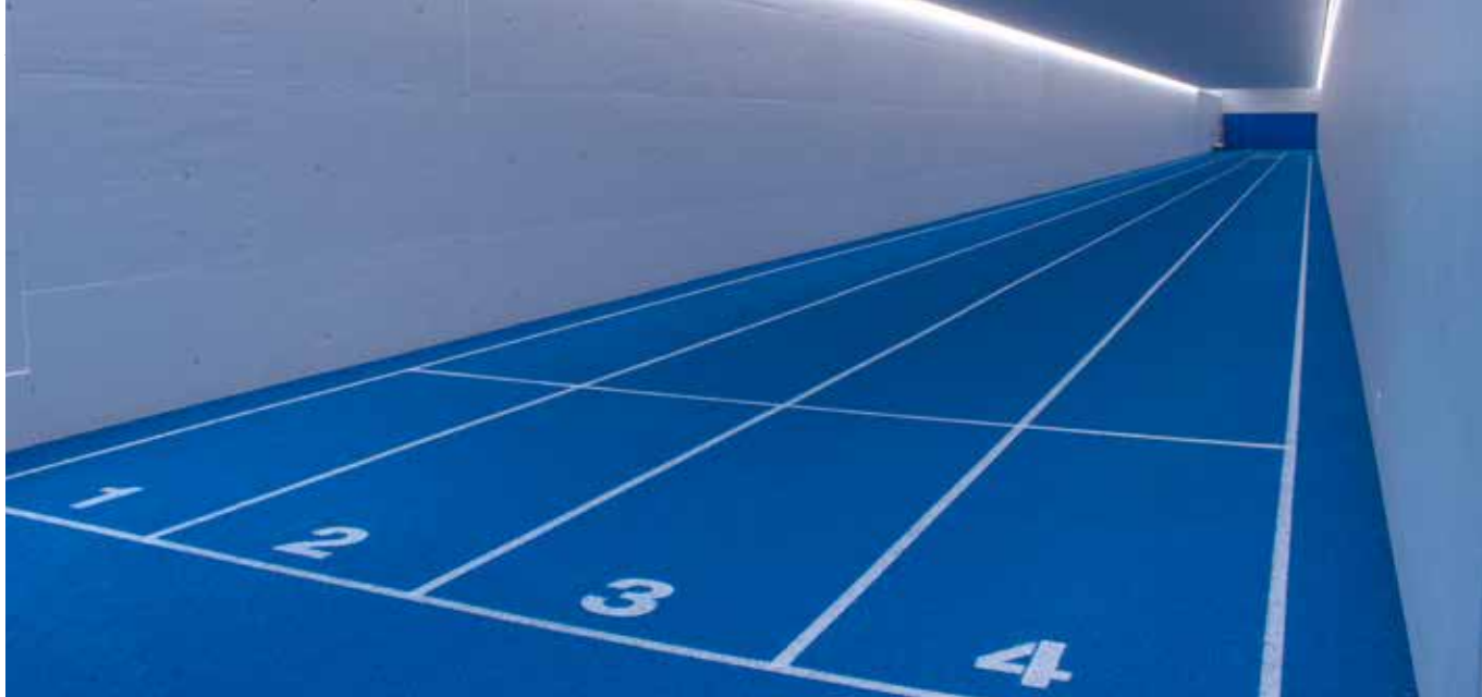
Dank holztechnischer Innovationen bietet die 150 Meter lange Sprint- und Sprunganlage in Aarau den Athleten die Möglichkeit zum ganzjährigen Training.
